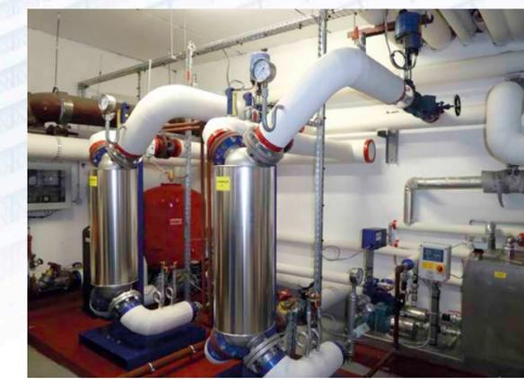
Notre Système **Compact Echangeur Noyé - ENCOsys®** permet une **optimisation maximale des rejets** (condensats) tout en maintenant une **consigne de température au degré près** dans un régime à faible pression et dans un **fonctionnement très stable et silencieux** (absences de sifflements).
